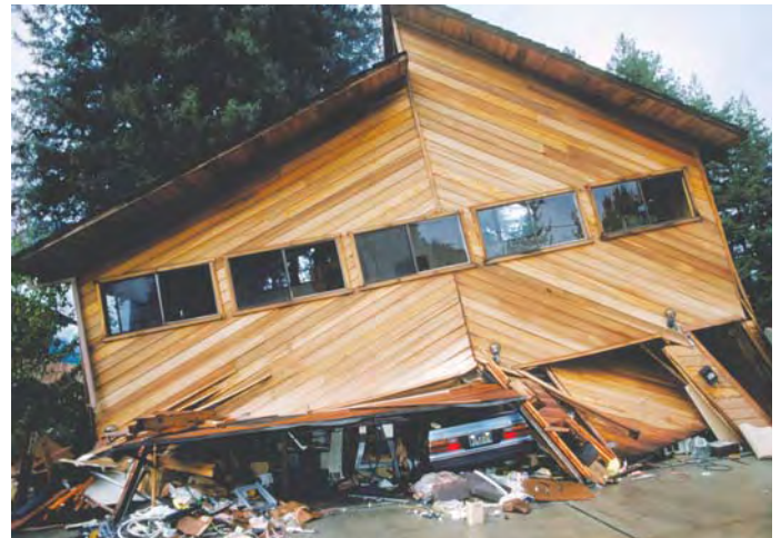
산타크루즈산에 있는 이 집은 1989년 강도 6.9의 로마 프리에타 지진이 발생했을 때 무너졌습니다 (USGS photo).
