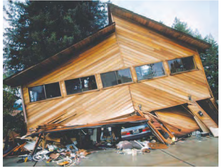
这所房子位于圣塔克鲁斯山区，在1989年6.9级的Loma Prieta地震中倒塌 (USGS photo)。
