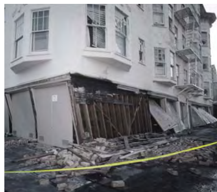
Ngôi nhà này trong vùng Santa Cruz Mountains bị sập trong trận động đất Loma Prieta cấp 6.9 vào năm 1989 (USGS photo).
