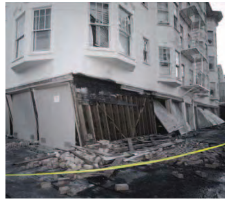
“Soft story”一般将第一层作为车库的建筑物，像这张照片里面的这栋，在湾区很普遍，在强烈地震中很危险 (USGS photo)。
