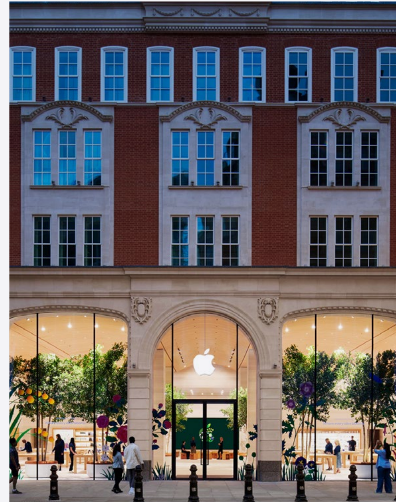
En 2022, nous avons ouvert le magasin Apple Brompton Road qui, comme toutes les installations Apple, est alimenté à 100 % par de l'électricité renouvelable.
