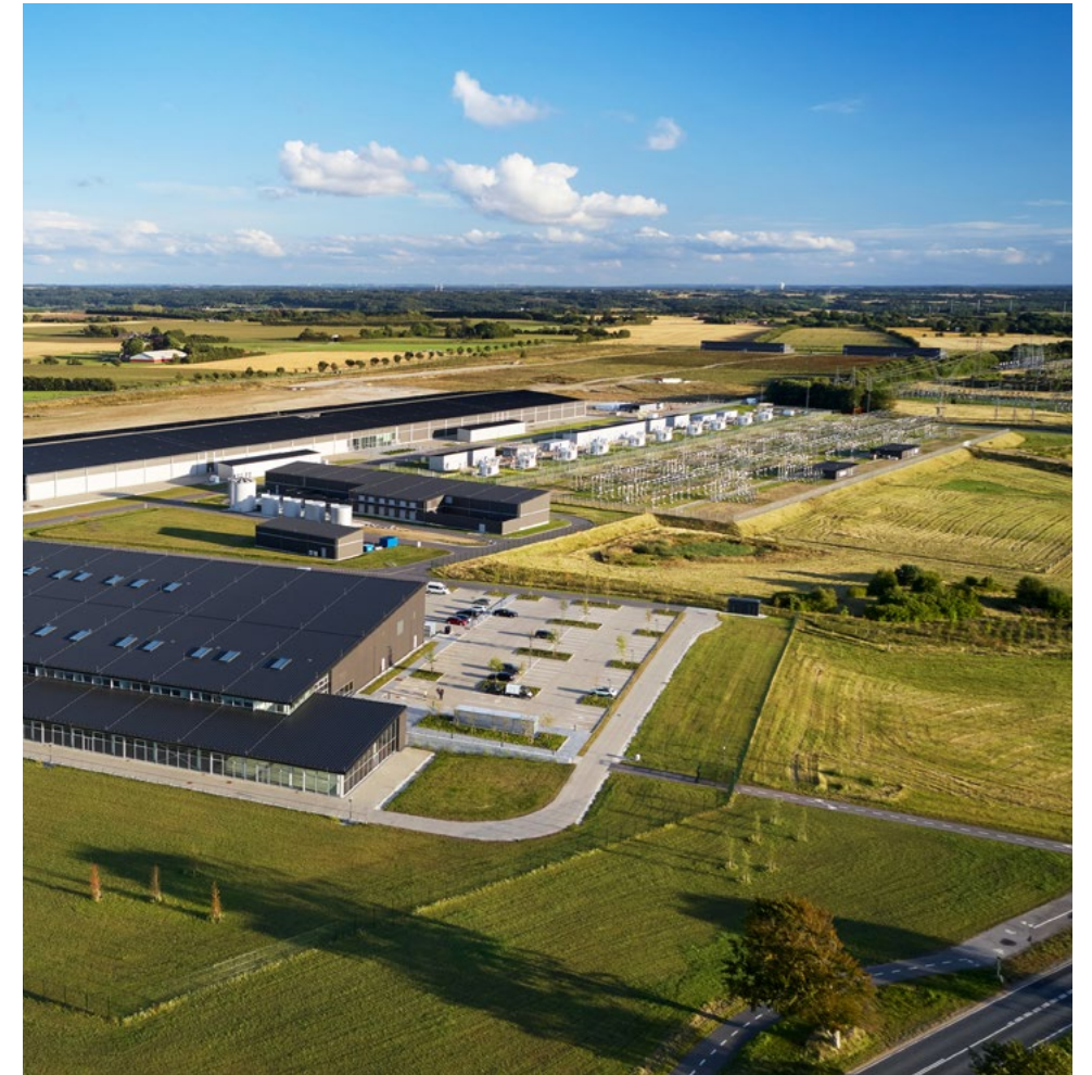
En 2023, notre usine de Viborg, au Danemark, est devenue la troisième à se voir décerner la certification TRUE Platinum, qui exige que plus de 90 % des déchets issus d'une installation soient recyclés, compostés ou réorientés en vue de leur réutilisation.
