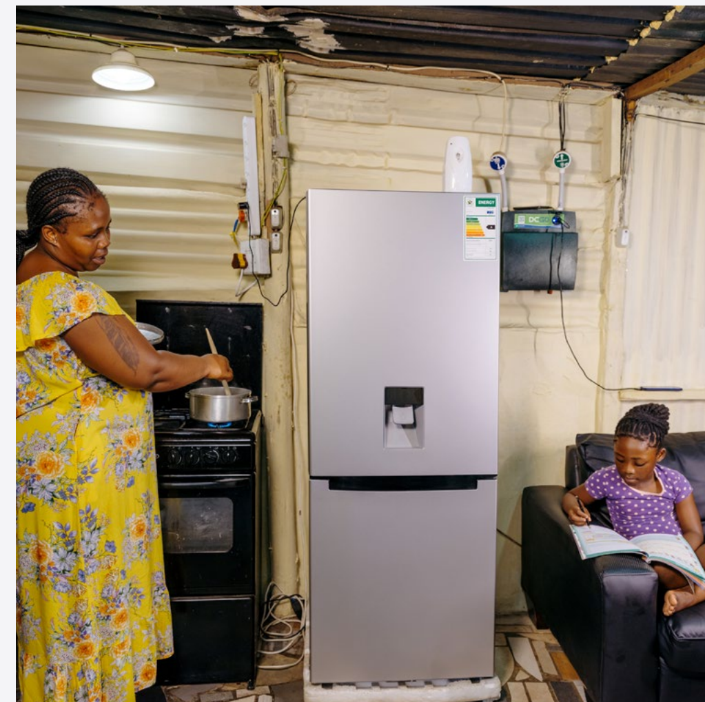
Grâce à l'un de nos projets en Afrique du Sud permettant un accès à l'électricité dans les habitations, les enfants peuvent maintenant faire leurs devoirs le soir et les familles peuvent cuisiner des repas à l'intérieur.
